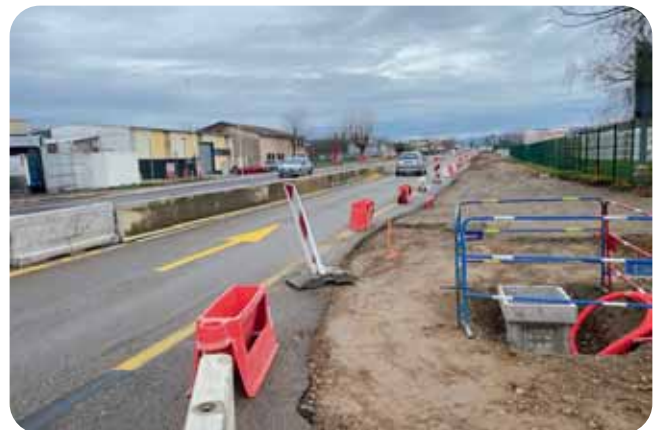
Travaux entrée de ville En cours
