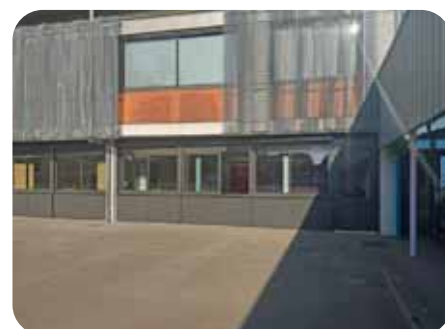
Rénovation, isolation du couloir bas
