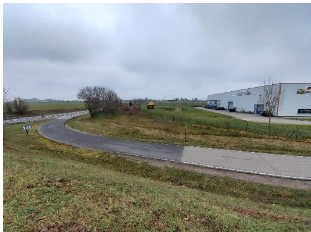
4 : Voie d'insertion à la RD518z
