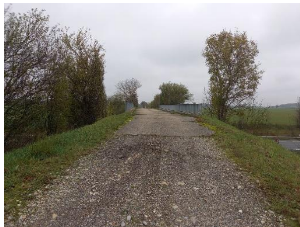
5 : Pont à démolir
