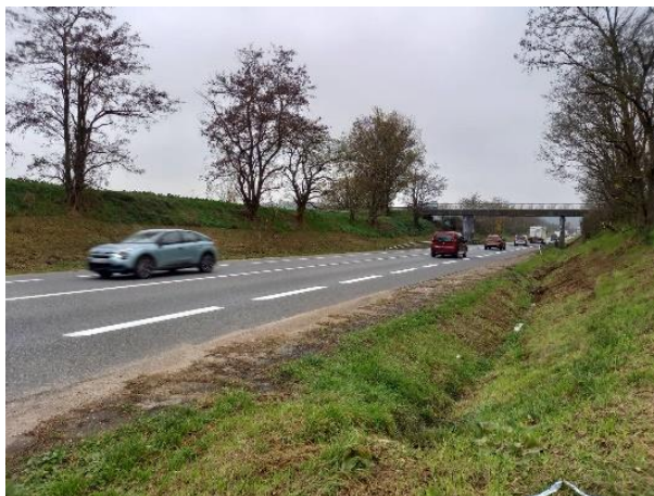
23 : RD518z passant sous le pont
