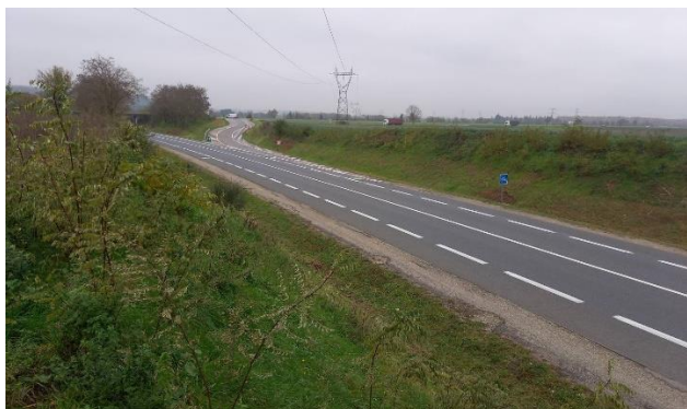
RD 518z avec bretelle d'accès à la RD 53a
