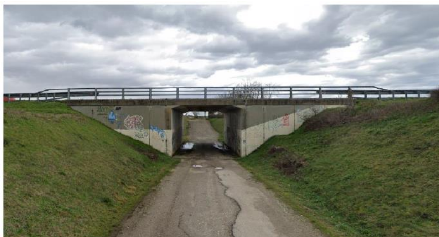
Figure 11 : Vue du PI depuis le chemin agricole en direction du nord (Source : AVP, Carrefour giratoire et aménagements connexes à Heyrieux, 29/06/2022)
