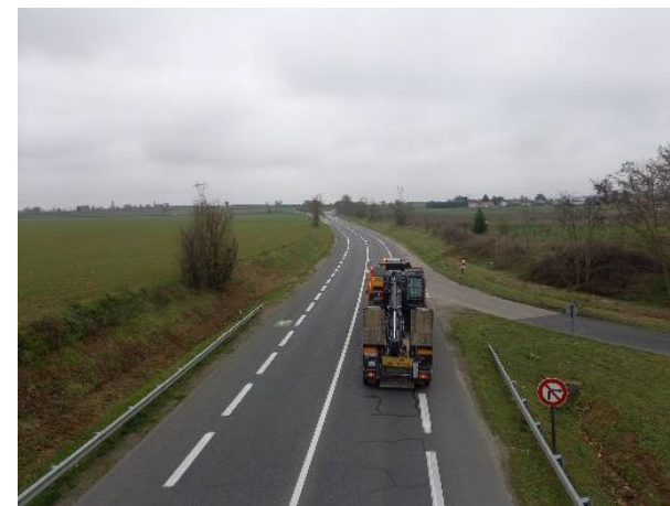
3 : Vue du pont à démolir
