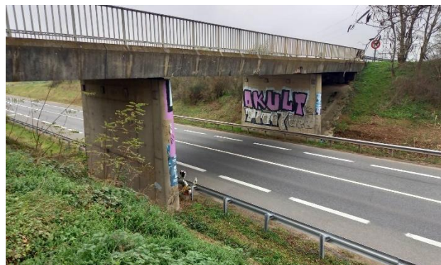
Pont de la RD 53a surplombant la RD 518z
