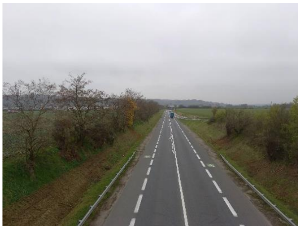
20 : Vue du pont de la RD518z
