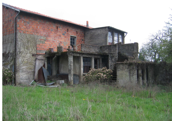
Vue arrière de la maison située sur la parcelle AL429
