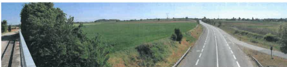
Différence topographique au droit de la déviation d'Heyrieux (RD 518z)
