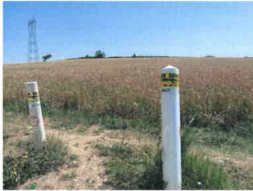
Borne indiquant l'emplacement de la canalisation d'hydrocarbure
