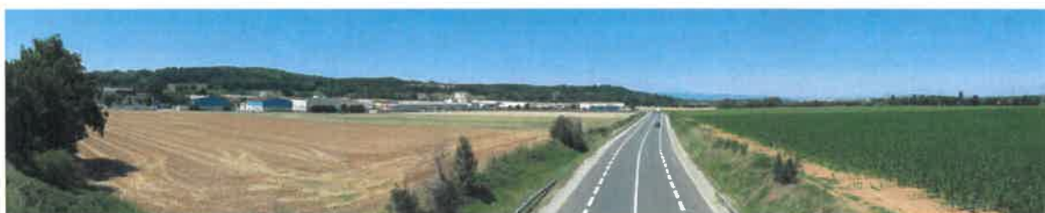
Pont de franchissement de la déviation (RD 518z) au Sud du Buclay
