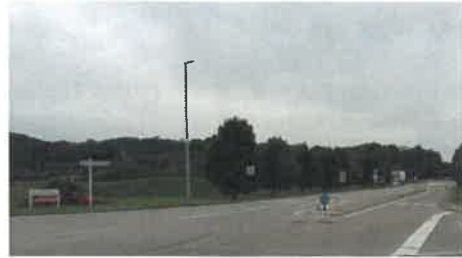
Aménagement paysager le long de la RD 518, partie Ouest
