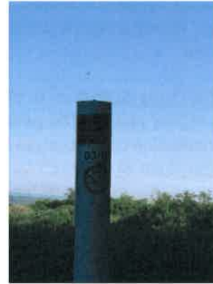
Borne indiquant l'emplacement de la canalisation d'éthylène
