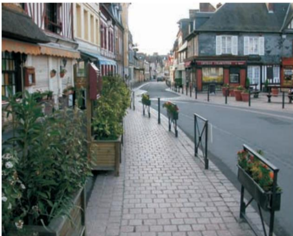
Section d'axe de transit - Photo CETE Normandie Centre
