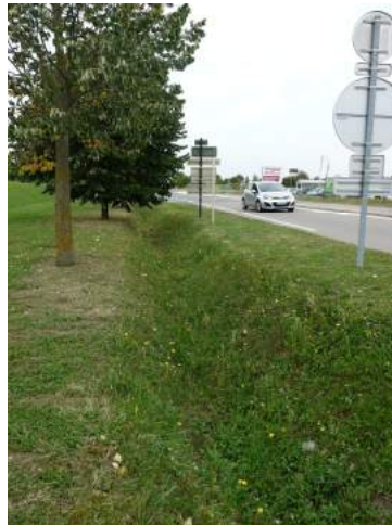
Noue aménagée le long de la RD 518 jusqu'à la rue des Balmes
