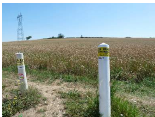
Borne indiquant l'emplacement de la canalisation d'hydrocarbure
