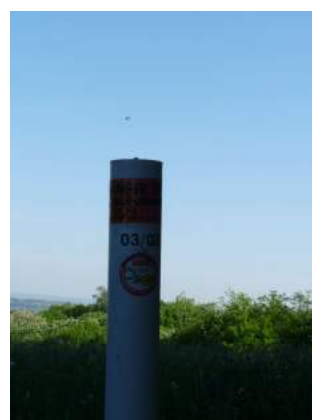
Borne indiquant l'emplacement de la canalisation d'éthylène
