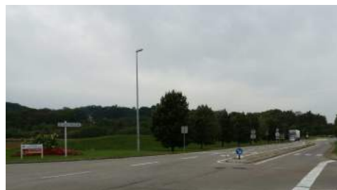
Aménagement paysager le long de la RD 518, partie Ouest
