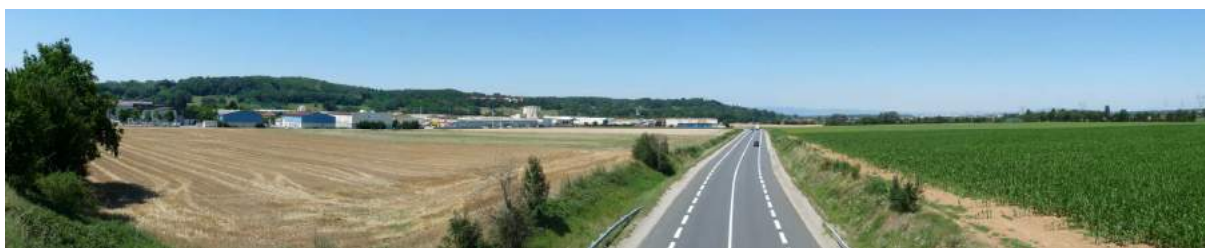
Pont de franchissement de la déviation (RD 518z) au Sud du Buclay
